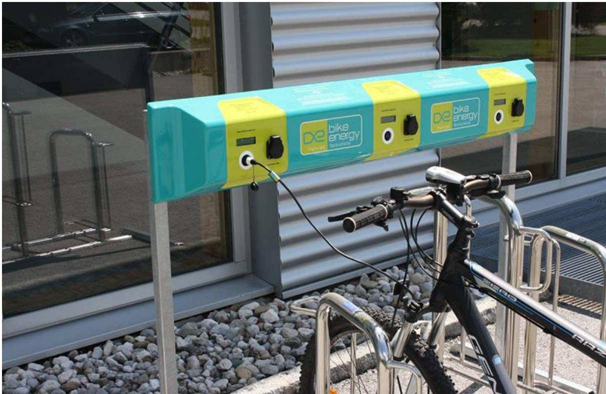
Abb. 16: Ladesäulen mit hauseigenen Anschlusskabeln
